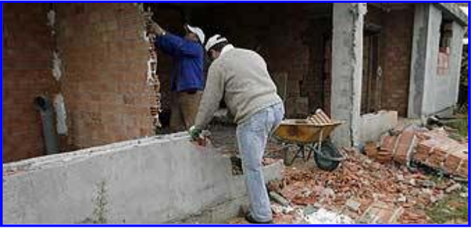
Derribo de una vivienda ilegal en Las Pitás, un entorno que está vigilado por la Policía Autonómica al ser zona BIC. / José Martínez.
